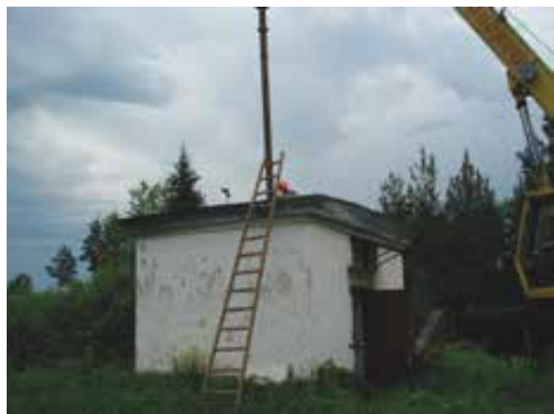
Демонтаж насоса скважины
